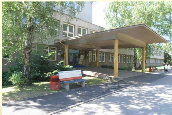
Hlavní vchod do budovy PK
